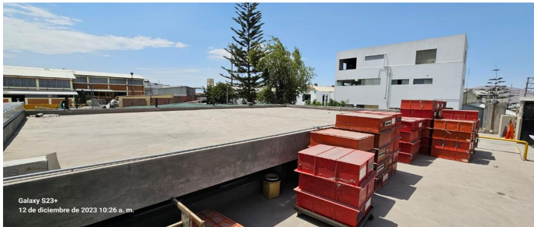
Figura N°4. Vista del área de distribución física, 2do nivel - Área destinada a comedor
