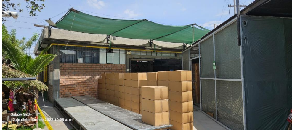
Figura N°5. Vista del área destinada a la construcción de escaleras para el acceso al comedor
